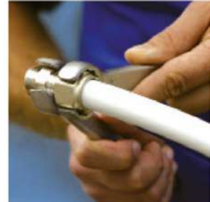
Usando chaves, rosqueie o monobloco na conexão necessária.
