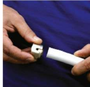
Encaixe e verifique pela abertura se o tubo está encaixado perfeitamente ao monobloco.
